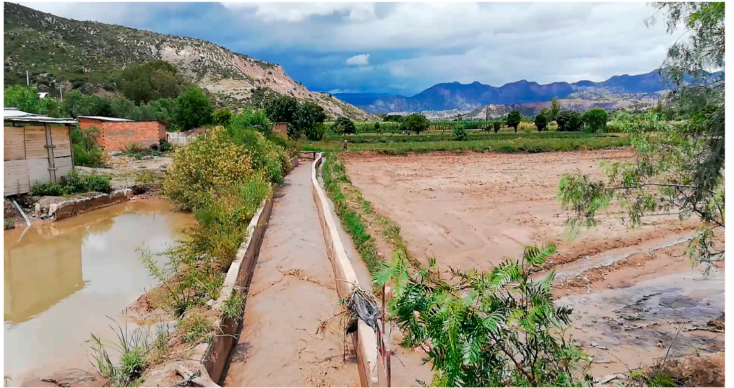
Primer tram del canal de reg. Presa des del riu Arche fins a la població de Capinota. Font pròpia.
