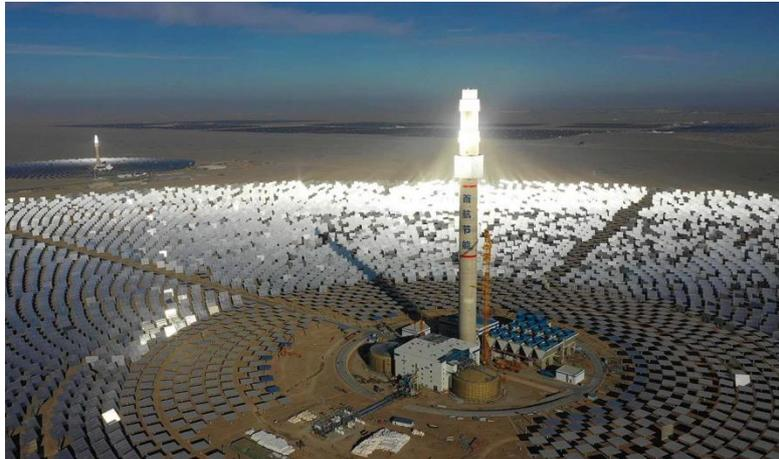
Figura 5.6 Central solar térmica de alta temperatura de Gansu (China), 100 MW [21]
