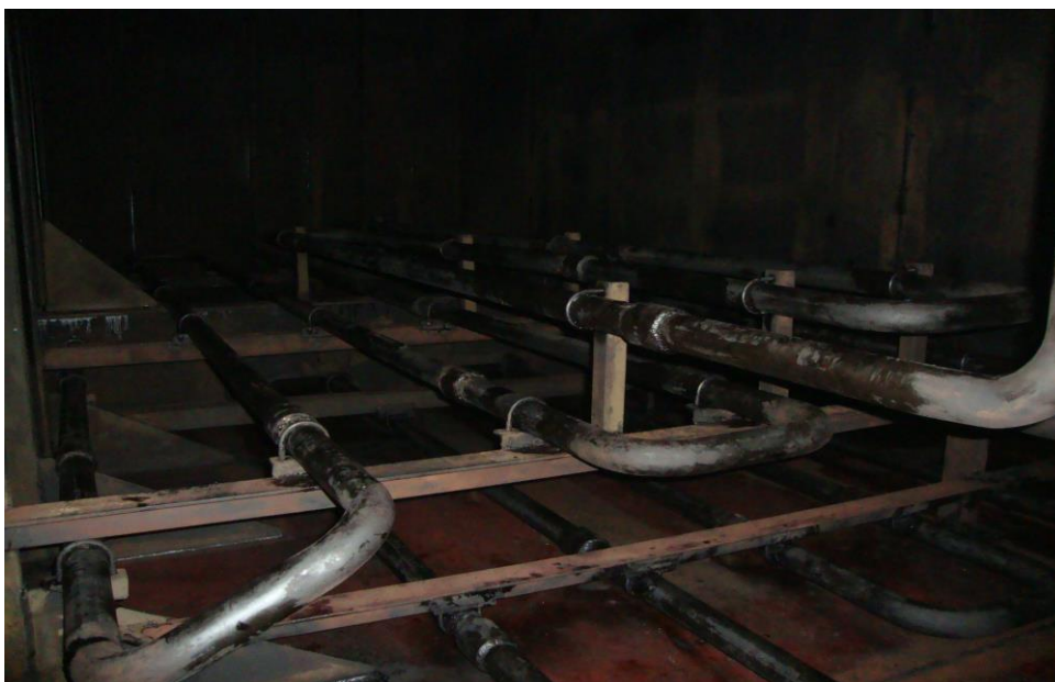
Figura 16: Calentador de vapor en un tanque de fuel-oil. Fuente propia.
