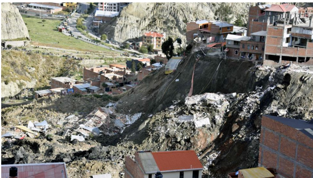
Figura 3.6. Vista de los daños del derrumbamiento por deslizamiento de tierras en La Paz, (La Vanguardia, 2019).
