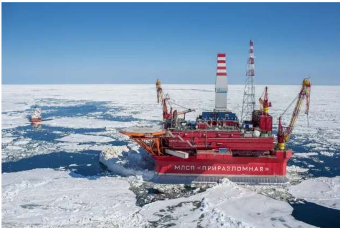
Figura 31. Plataforma petrolífera Prirazlomnaya en el mar de Pechora. Fuente: www.gazprom.com/projects/prirazlomnoye/
