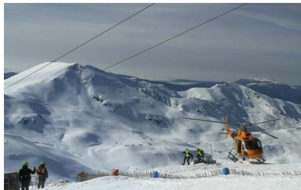
Figura 3: Reparació de la instal·lació durant la temporada 2019/2020.
