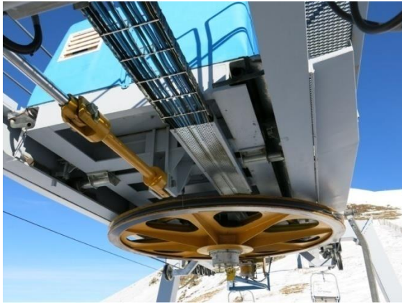
Figura 8: Sistema de tensió i volant motriu. [4]
