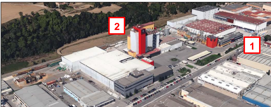
Figura 5: Vista aérea del complejo industrial del Grupo Gallo en Granollers.[8]
