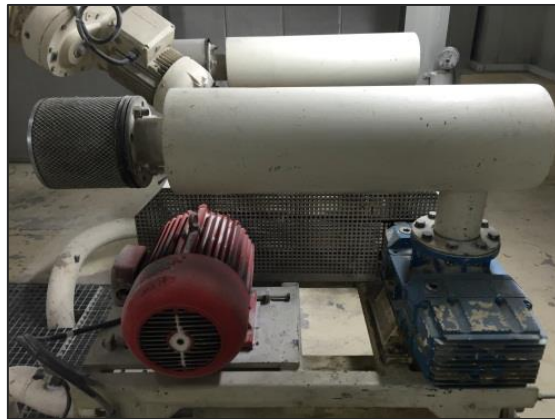
Figura 44: Soplante para transporte de materia.
