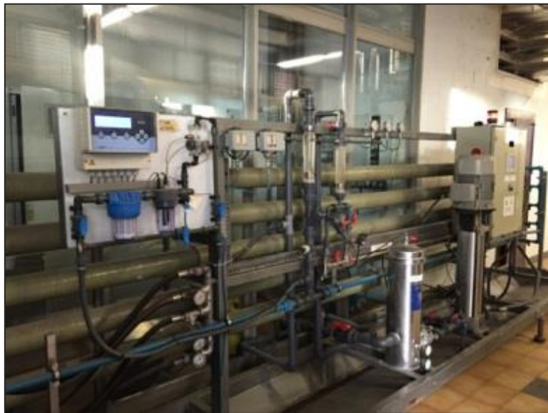
Figura 37: Instalación osmosis.
