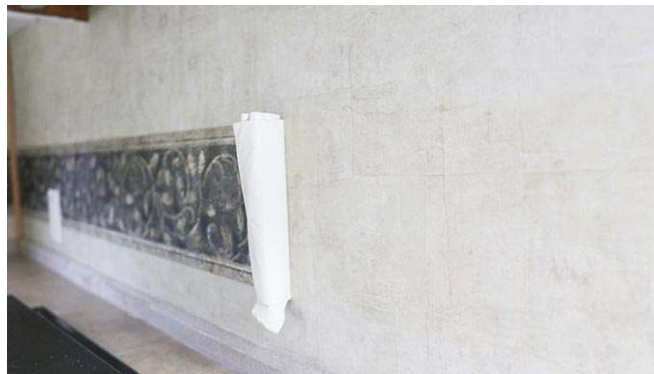
Il·lustració 22. Paret acabada amb Laminat de Fusta i una tira de Vinil
