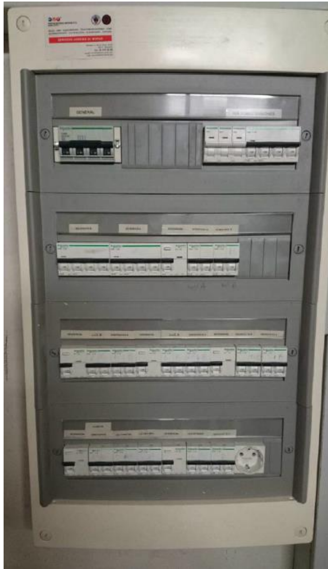
Fig 3.27. Quadre general de protecció de l'edifici [13].
