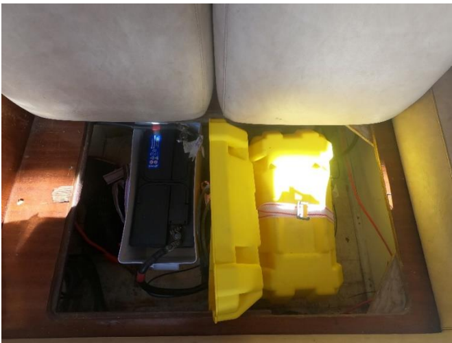
Figura 34. Baterías de 12 V conectadas en serie
