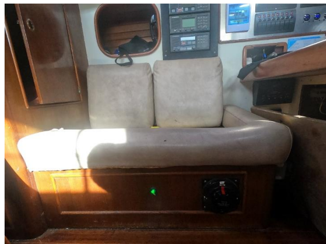
Figura 35. Desconectador de baterías del servicio de 24 V
