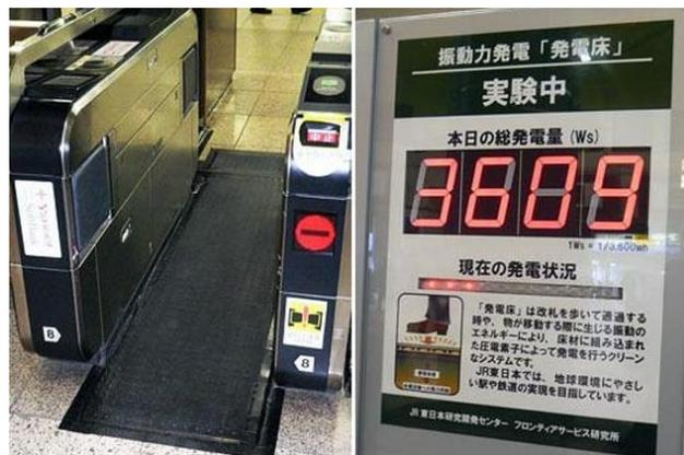
Figura 6. Instalación de baldosas piezoeléctricas en la estación de Tokio. Obtenido de [21]
