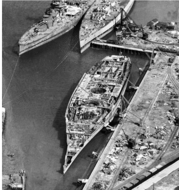
Imagen 4. Desguace de buques mediante el método Alongside. Fuente: Pinterest
