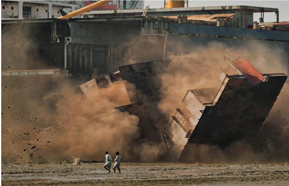
Imagen 1. Caída de sección lateral de un buque mercante. Fuente: shipbreakingplatform.org
