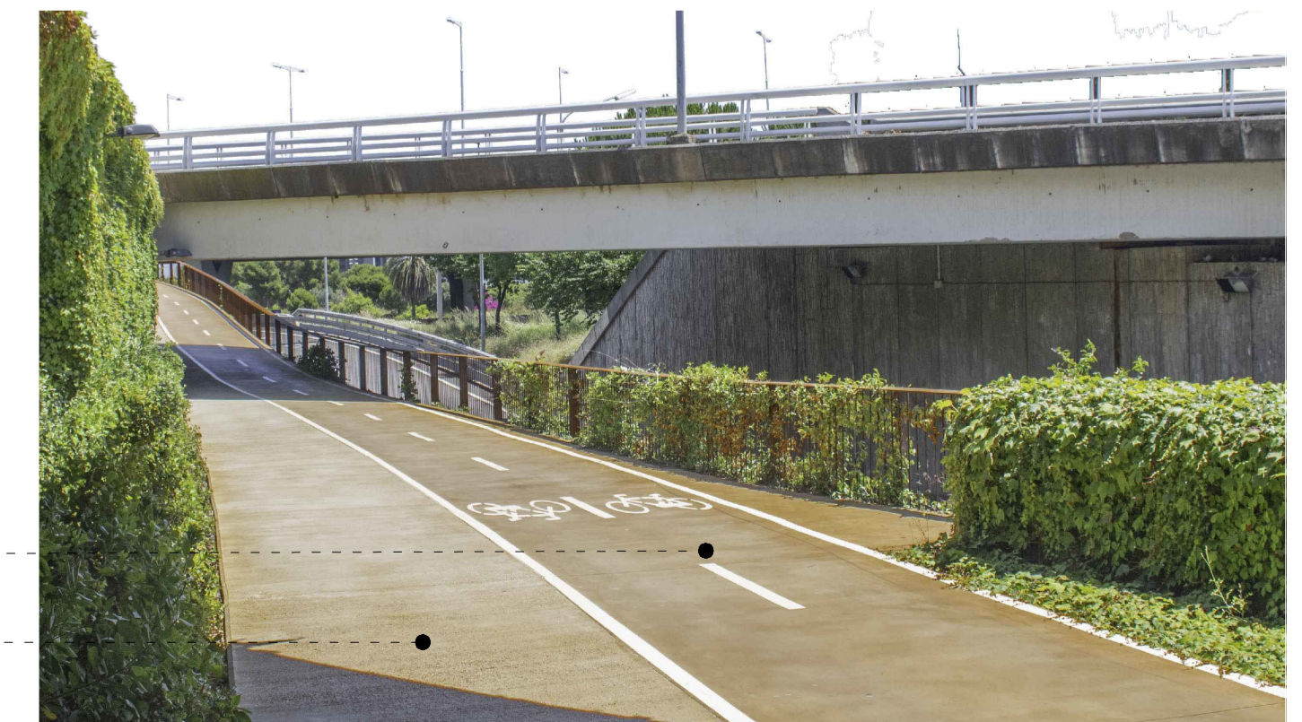
MATERIALIDAD DE LAS NUEVAS ACERAS Y PASEOS PEATONALES Fotografía del proyecto ejecutado de conexión entre Barcelona y espigues del Llobregat de batlle i roig
