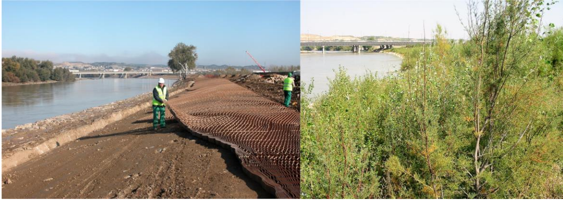
Fig. 3 Construcción de la defensa del Parque del Agua. 2006, y soto del Parque del Agua. 2009. Fuente: (Pellicer y Sopena, 2019)
