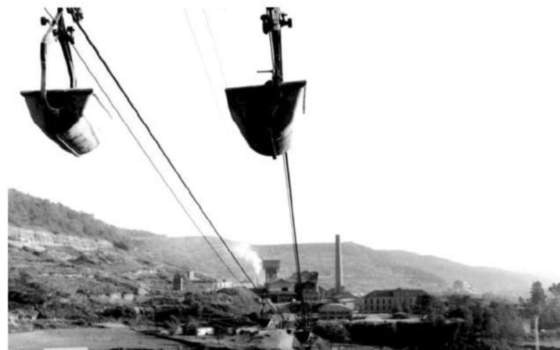
LLEGADA A SÚRIA DE LA LÍNEA AÉREAS DE VAGONETAS CARDONA-SÚRIA Fuente img: Tesis Minería, transformadora del paisaje natural y humano, de José Antonio Giménez Ruiz por la Universidad de Alicante
