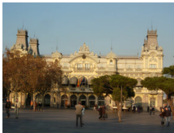
Figura 3: Edificio sede de la Autoridad Portuaria de Barcelona
