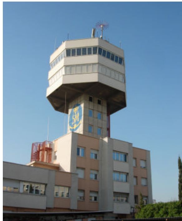
Figura 12: Torre de control de la Capitanía Marítima de Barcelona.
