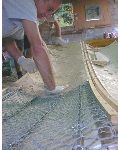
Fotografía 10. Colocación manual del mortero.
