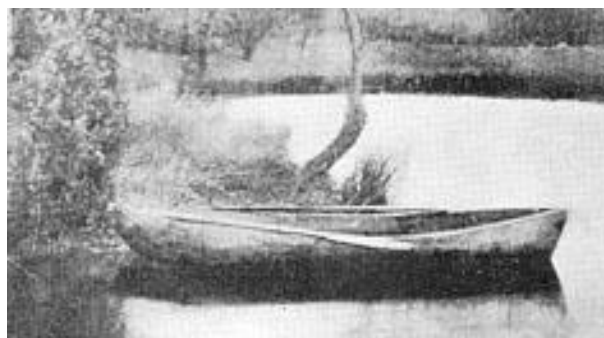
Fotografía 1. Bote construido en ferrocemento por Joseph Louis Lambot en 1848.
