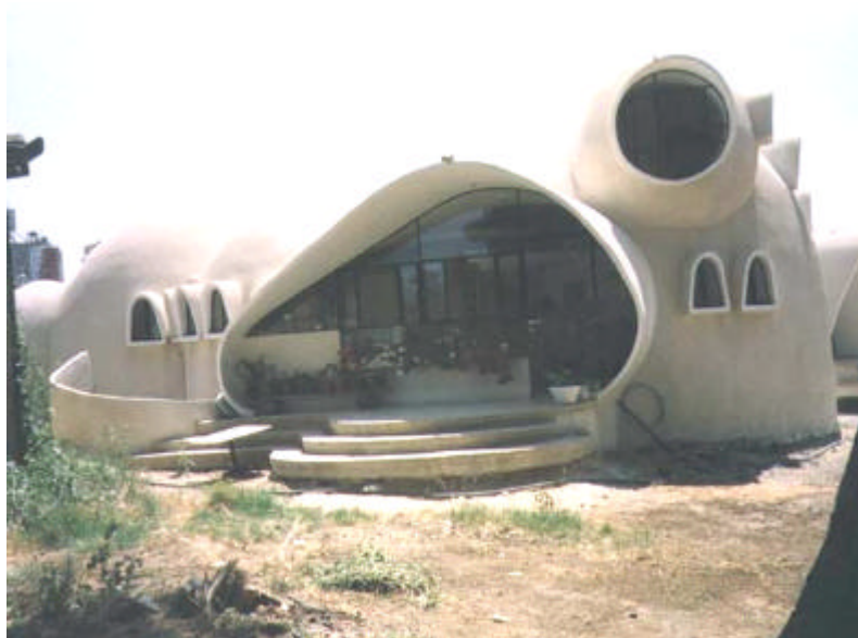
Foto 7. Vivienda poco convencional construida en ferrocemento.
