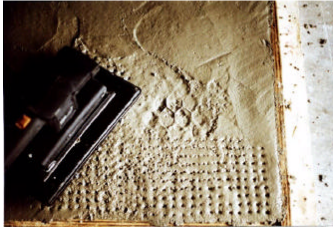
Fotografía 11. Vibración mecánica del mortero. [Bedoya 96].
