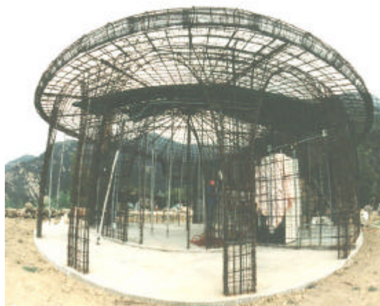
Fotografía 4. Acero de armazón para una estructura de ferrocemento.
