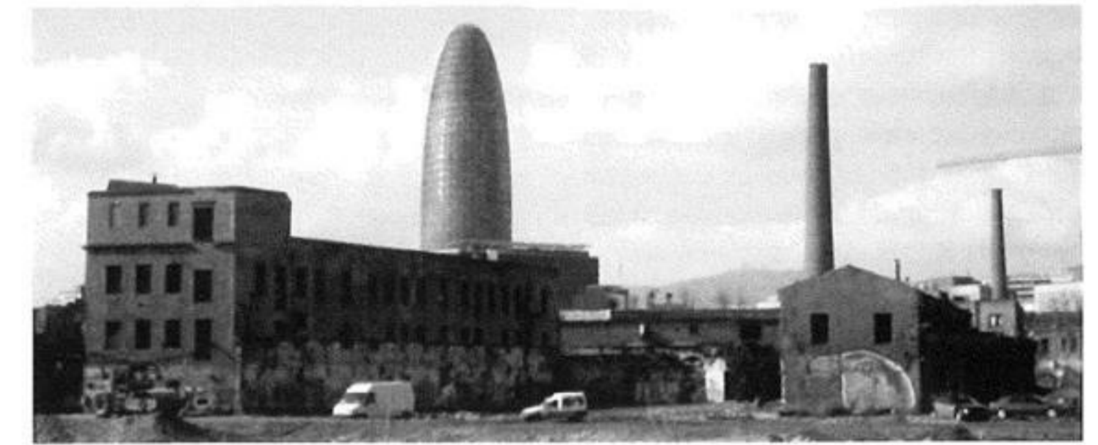
Part del complex industrial. Foto: GRC Studio.
