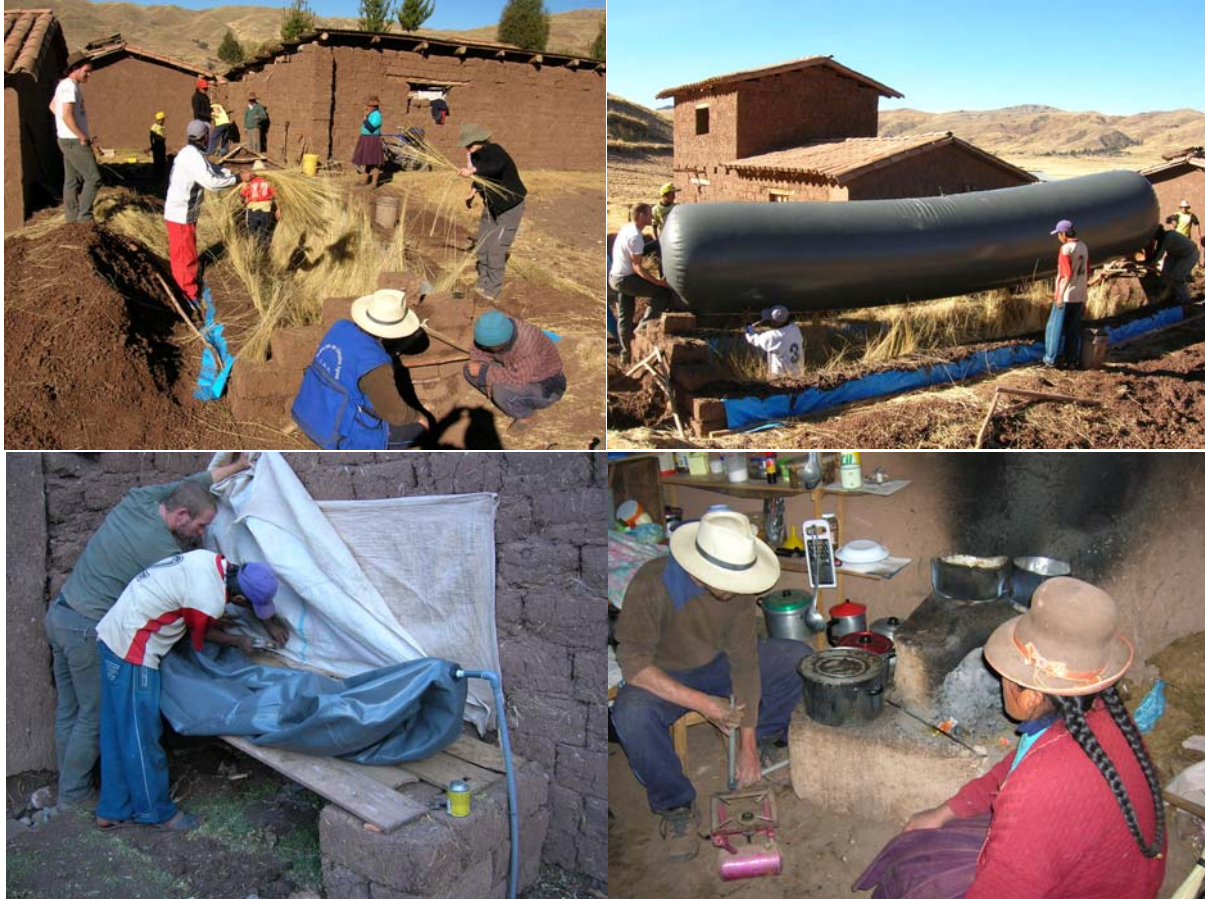
Figura 1. Implementación de un biodigestor mejorado de PVC dentro de un curso de capacitación de yachachiq a Yanaoca, Cusco (2008)
