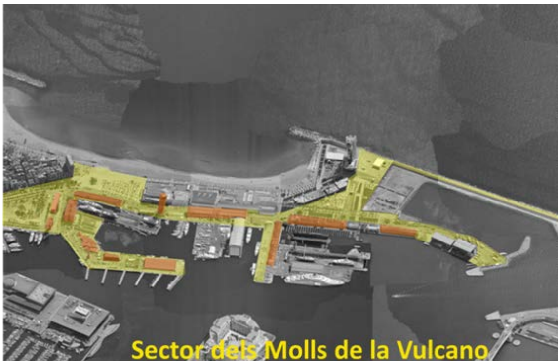
Figura 11. Imatge aèria del Moll dels Pescadors fins a la Nova Bocana: la continuïtat de l'espai públic i els seus valors patrimonials
