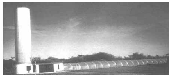
Figura 8. Secador mixto para madera. Avances en Energías Renovables y Medio Ambiente Vol. 7, N° 1, 2003. Argentina. ISSN 0329-5184.
