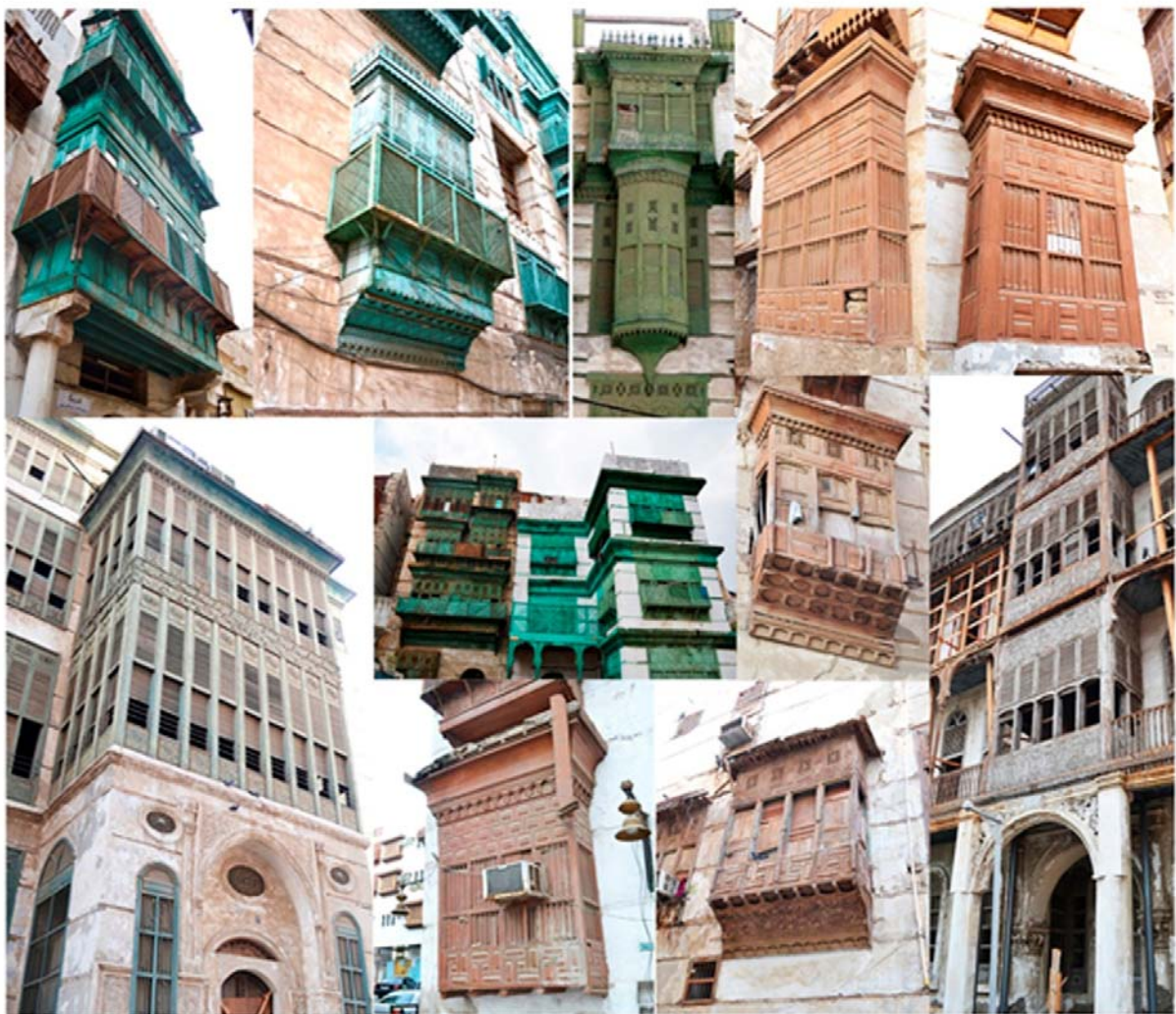
Figura 2. Ejemplos de diversos tipos de roshan de la zona del Al Balad , Jeddah, donde se aprecian las diferentes tipologías, los de tipo cajón y los monumentales, por agregación de los primeros.
