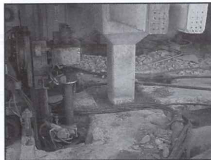
Figura 11 - Micropilotes alrededor de pilares. Preparación.
