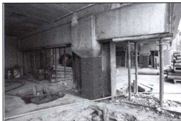
Figura N° 15 - Apeo provisional del pilar. Puntales en zona interior.
