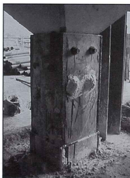
Figura N° 16 - Encamisado metálico del pilar 18 con los pernos de conexión.
