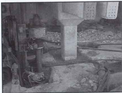
Figura 11 - Micropilotes alrededor de pilares. Preparación.
