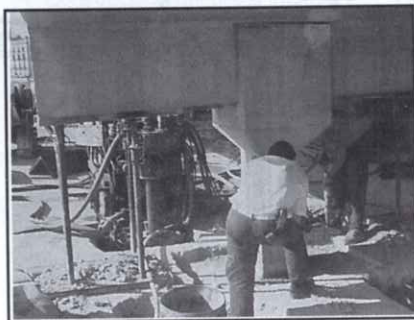
Figura 12 - Micropilotes alrededor de pilares. Eliminación capa de compresión.
