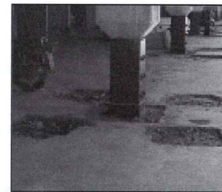
Figura N° 17 - Vista de los pilares reforzados.
