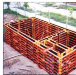
Planta de Tratamiento, Buenos Aires
