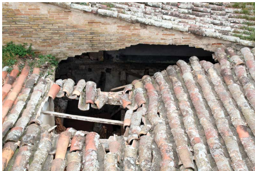
Figura 12 Formación de arco de descarga a partir de la rotura de pared de carga
