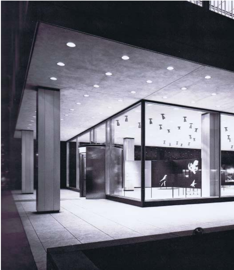
Acceso al vestíbulo. Access to the lobby.
