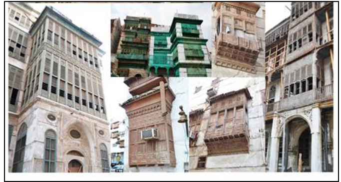
Figure 1. Ejemplos de diversos tipos de roshan de la zona del Al Balad, Jeddah, donde se aprecian las diferentes tipologías, los de tipo cajón y los monumentales, por agregación de los primeros. (Fotos de los autores)
