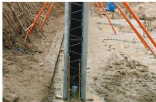
5/ajuste alineado, niveles lateral y frontal, y apuntalado
