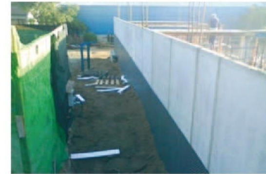
9/drenaje, impermeabilización y relleno de trasdós
