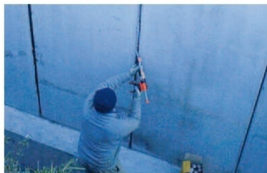
7/sellado juntas verticales entre placas y horizontales
