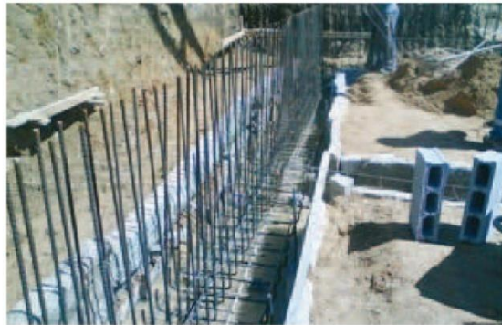
1/montaje ferralla cimentación y esperas
