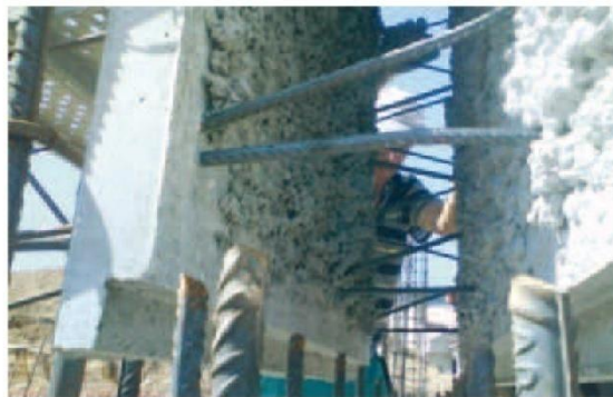
4/posicionado del prefabricado sobre esperas y bajada del panel
