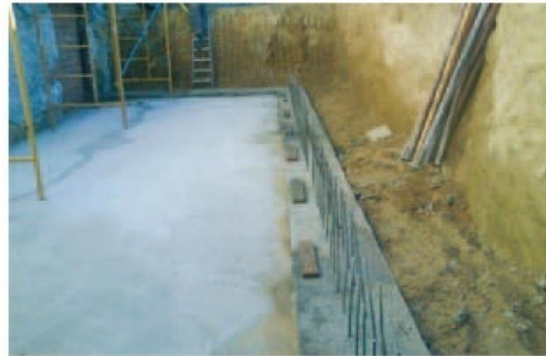
2/hormigonado de cimentación, alineación de esperas y colocación de tajos de junta línea interior
