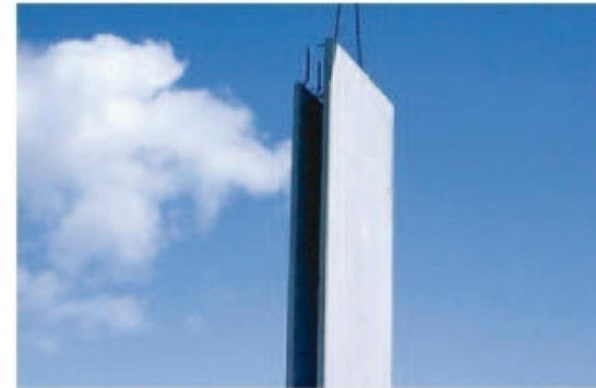
3/traslado pieza prefabricada (camión grúa-grúa torre)
