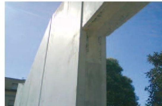
8/relleno alma del muro 'in situ'
