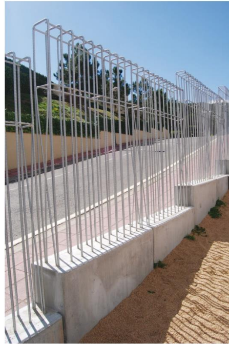
VALLA PERIMETRAL_metàlicas empotradas
