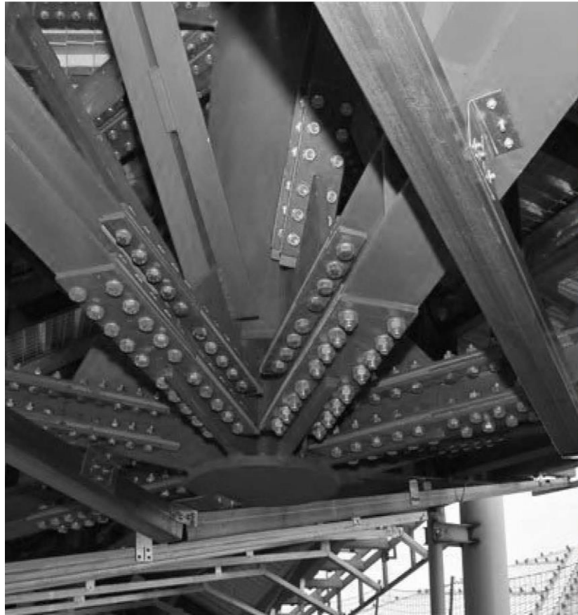
El encuentro entre las estructuras metálicas se fija con pernos estructurales
