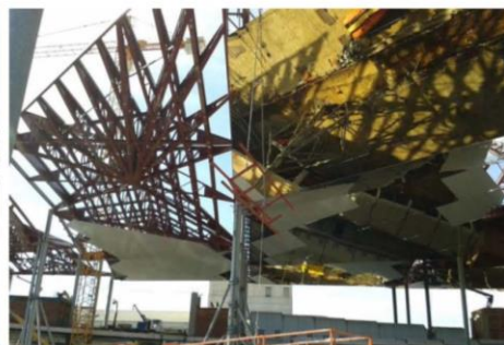
Crujías Estructurales y superficie inferior topográfica
