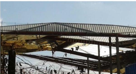
Geometría compleja / cubierta chapa corrugada
