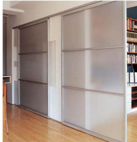
Ejemplo de propuesta para muros divisorios en las Botigue. Panel opaco deslizable, fácil desmontable.
