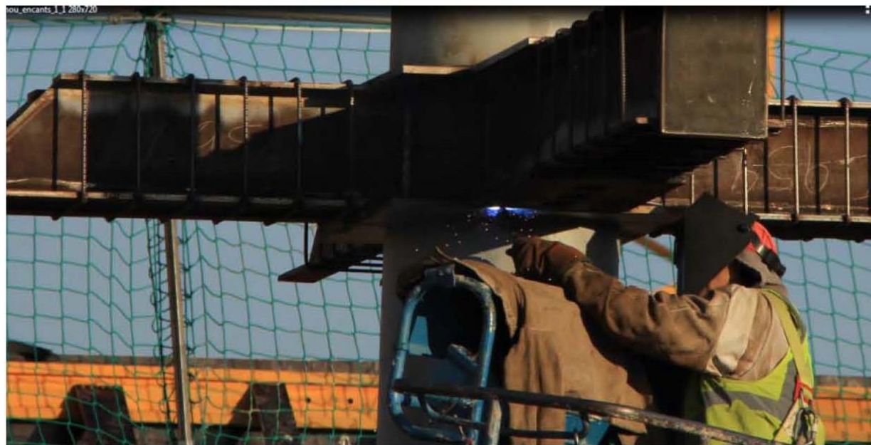
Unión de la crucería al pilar por medio de soldadura
