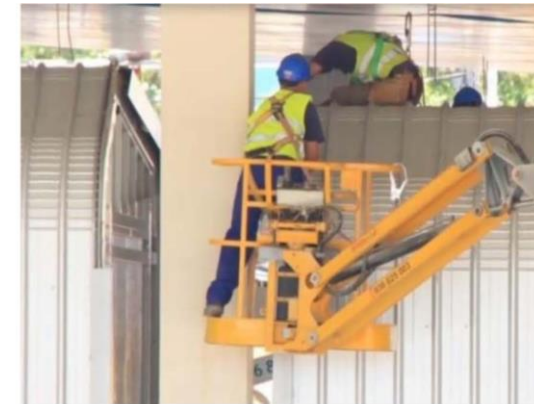
Colocación de remates y esquineros
