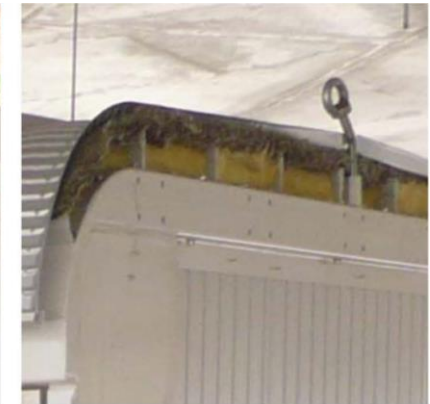
Núcleo de lana de roca
