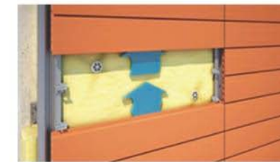
Sujeci3n mediante sistema clips – Junta abierta Piezas Huecas ceràmica de terracota hueca roja (300 x 1480 x 40 mm)
