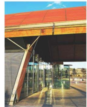
Sujeci3n mediante sistema clips – Junta abierta Piezas Huecas ceràmica de terracota hueca roja (300 x 1480 x 40 mm)
