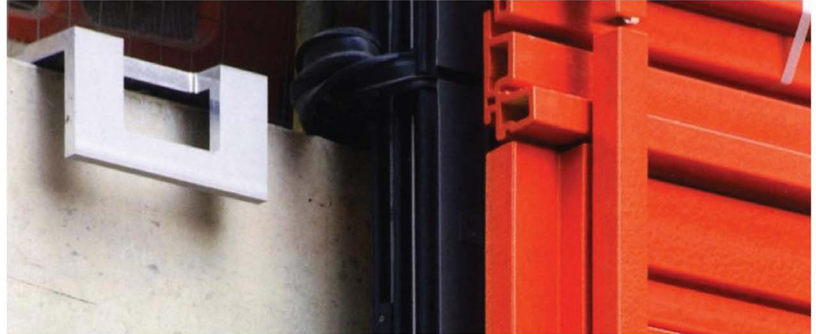
Pletina de acero galvanizado en "L" fijada al forjado.
