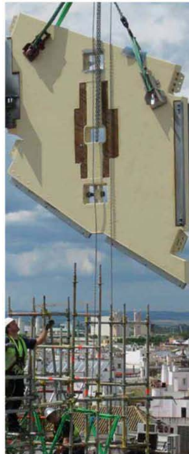
CONSTRUCCIÓN METROPOL PARASOL
