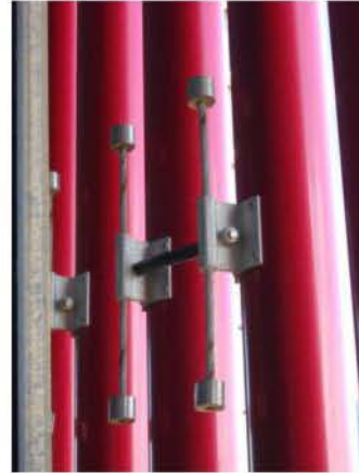
ELEMENT ESTABILITZADOR (TMD)
