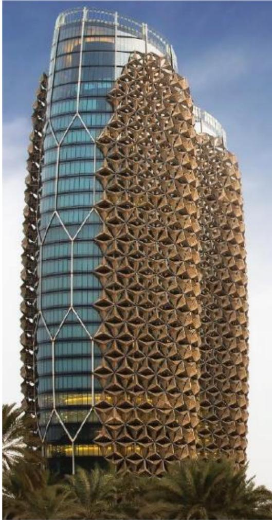
Las fachadas de las torres están compuestas por dos cerramientos, el primero un único basamento de vidrio que tiene una estructura de forma de diamante que en ella lleva los puntos de apoyo para toda la estructura dinámica y el segundo inspiradas en las tradicionales celosías árabes del tipo mashrabiya, proporcionan sombra a las dos torres de una manera dinámica e innovadora, lo que ha hecho que se conviertan en un icono de la ciudad.
