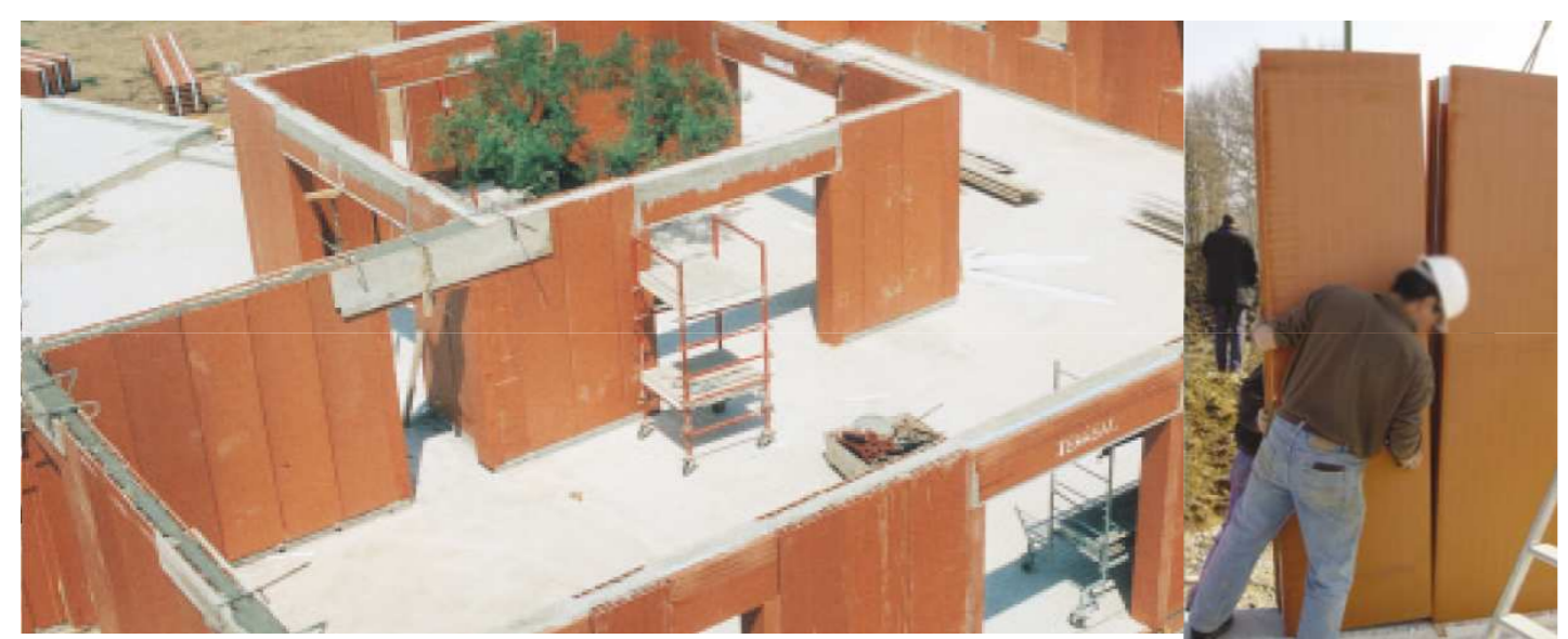
Terral-briques monolithes. Piezas de gran formato listas para ser colocadas
