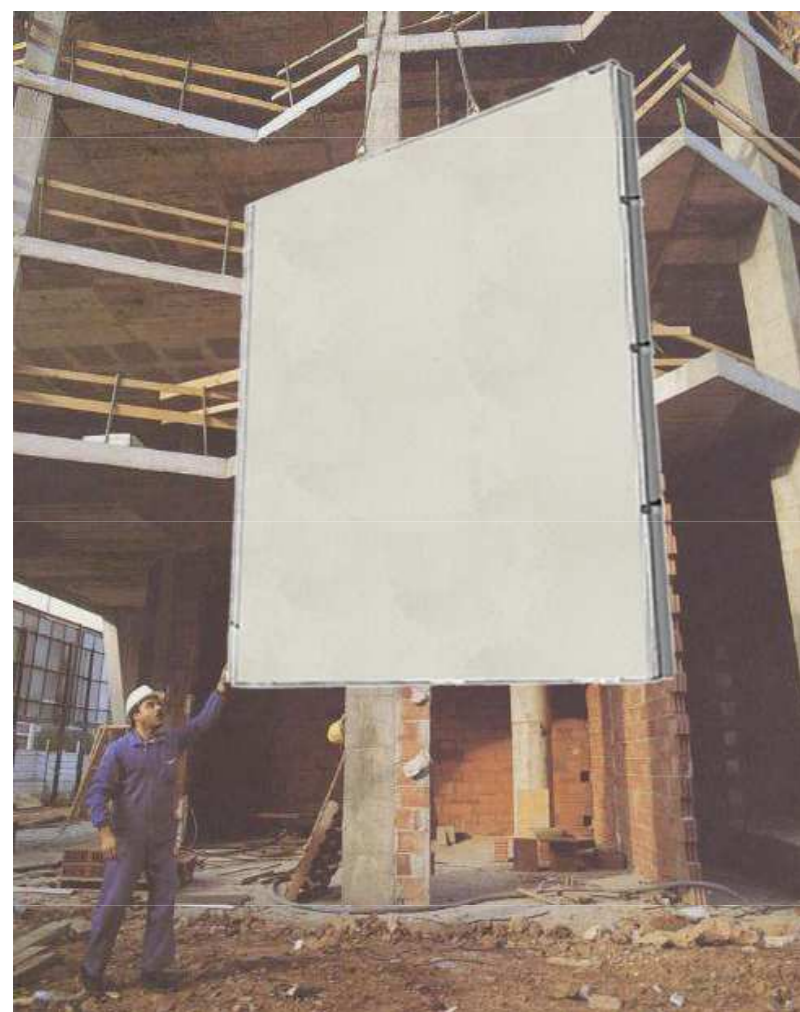
1. La pieza llega en obra y mediante maquinaria auxiliar se sube hasta su ubicación.
