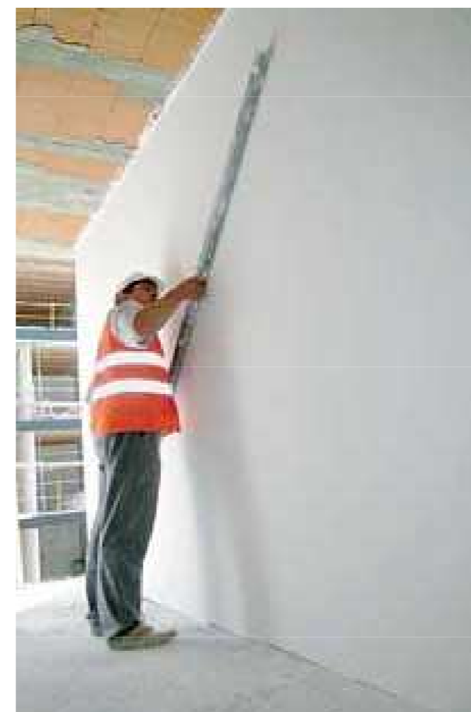
3. Ensamblaje y últimos repaos in-situ.
