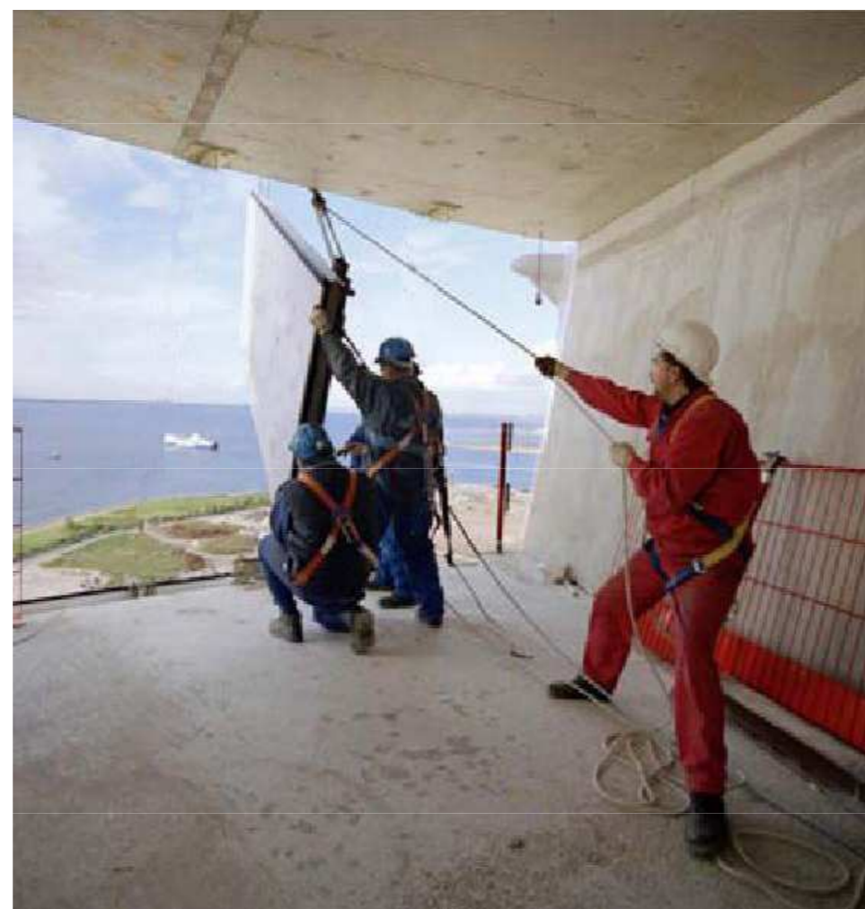
2. Un equipo de técnicos montadores pone en su lugar el tabique a instalar
