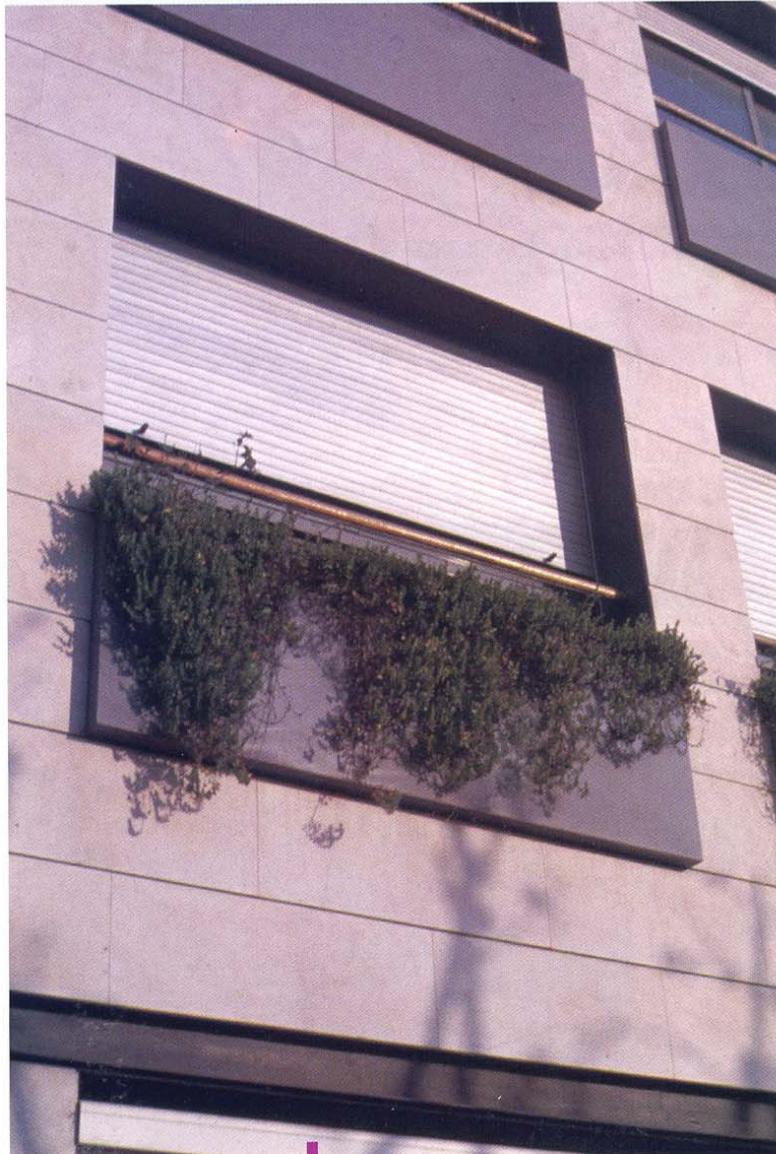
La construcción actual ha permitido la formación de mayores huecos en fachadas de obra de fábrica, ya no con función portante, soportadas sobre estructuras de barras
