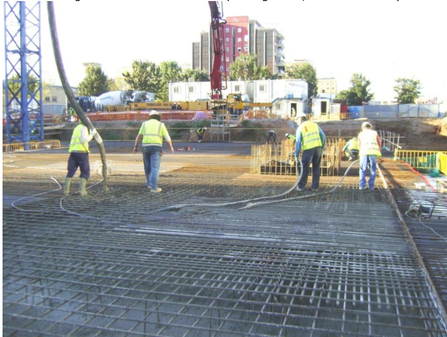
Fotografía 1: Situación en obra (hormigonado, Barcelona 2012)
