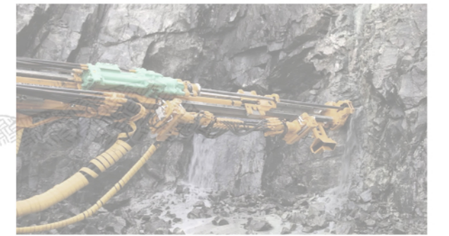
PERFORACIÓ DE BARRENOS AMB JUMBO DE PERFORACIÓ
