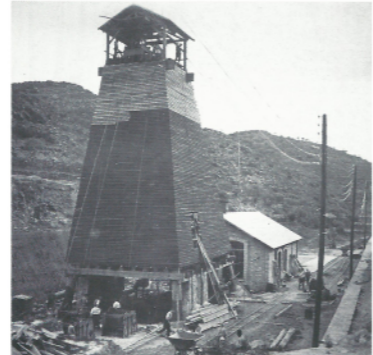
Construcció del castell Alberto el 1926 (arxius històrics de Cardona)
