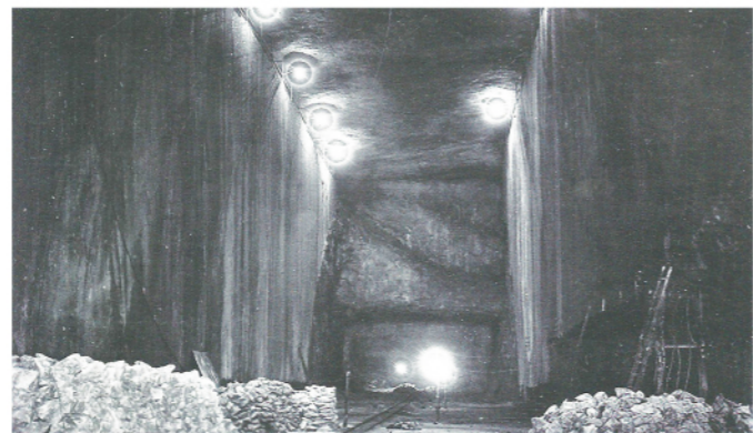
Explotació subterrània de les mines Pou del Duc, obertes per a la recerca de potassa. Les mines van estar en actiu fins el 1934 quan es va inundar per topar-se amb un aguller.
