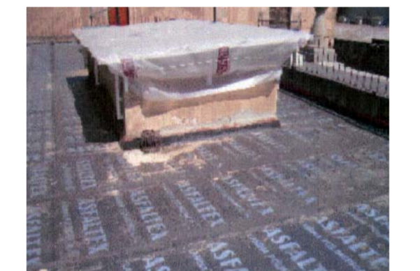
Impermeabilització a posteriori de la coberta
