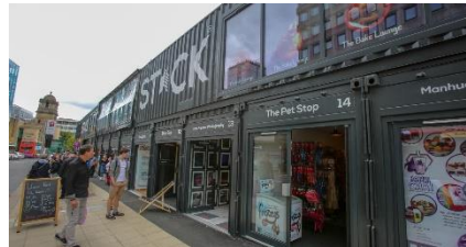
Figures 3, 4 i 5. Aplicacions de contenidors marítims com a escola, piscina i centre comercial.
