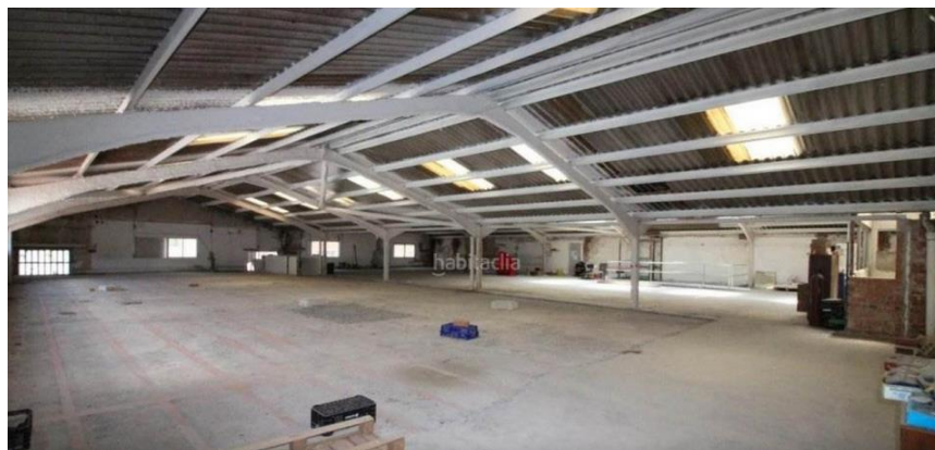
Il·lustració 24. Interior nau industrial
