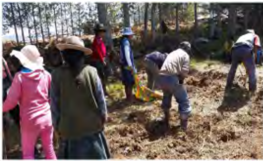
Figura 3a. Trabajo comunitario en la I.E.50106 para la construcción del humedal construido.
