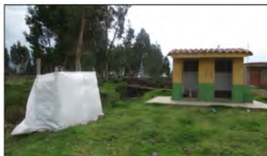
Figura 1b. Letrina provisional y S.H. de la plaza de Haparquilla.
