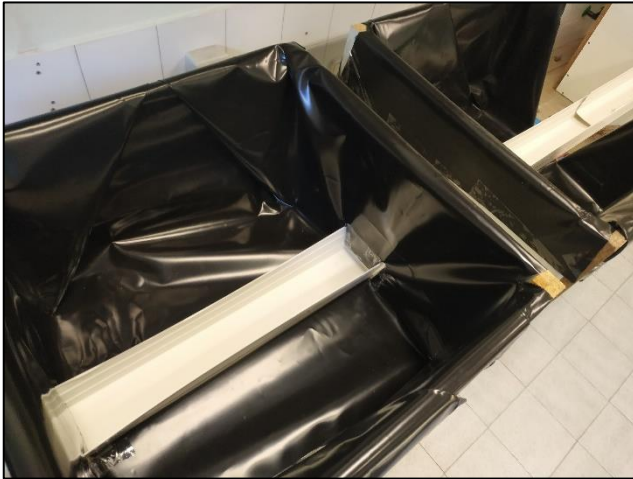
5 Col·locació del canal.
