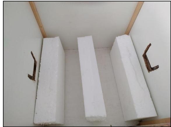
2 Col·locació del poliestirè expandit per la base del canal.
