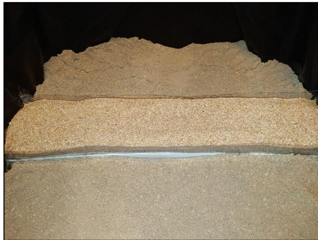
Figura 7.3.2.11 Canal omplert de sorra i sauló a nivell.
