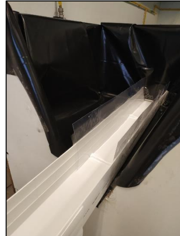
6 Ampliació de l'altura del canal amb les làmines de PVC.
