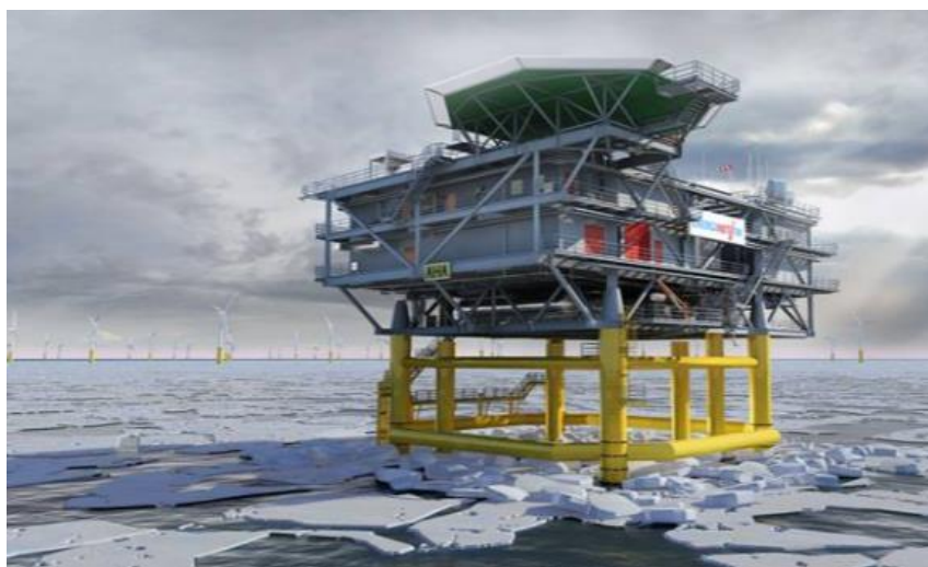
Figura 4.11: Subestación de transformación del parque Anholt en los meses de invierno. Fuente: [14].
