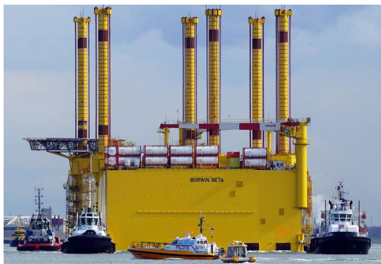
Figura 4.26: Subestación de transformación BorWin beta. Fuente: [38].
