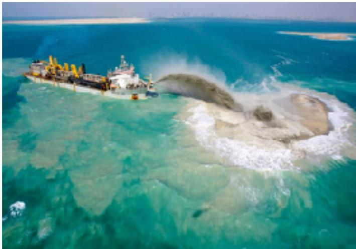
Figura 12: Representación del método de bombeo de arena para la formación de la isla artificial.
