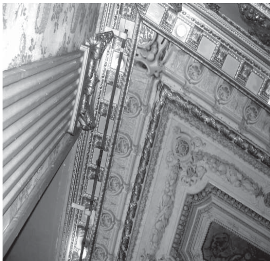
Figura 4. Detall del sostre del Palau Castell de Pons.
