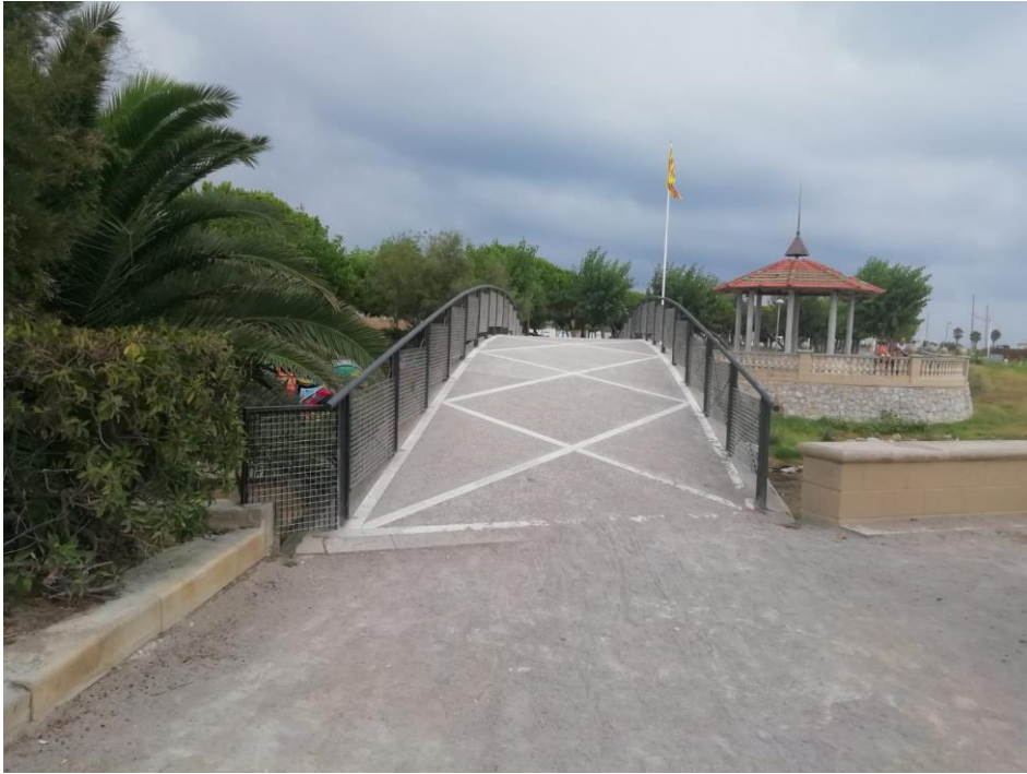
Fotografía 8. Vista de perfil de la pasarela a remodelar (W-E). Fuente: Propia.
