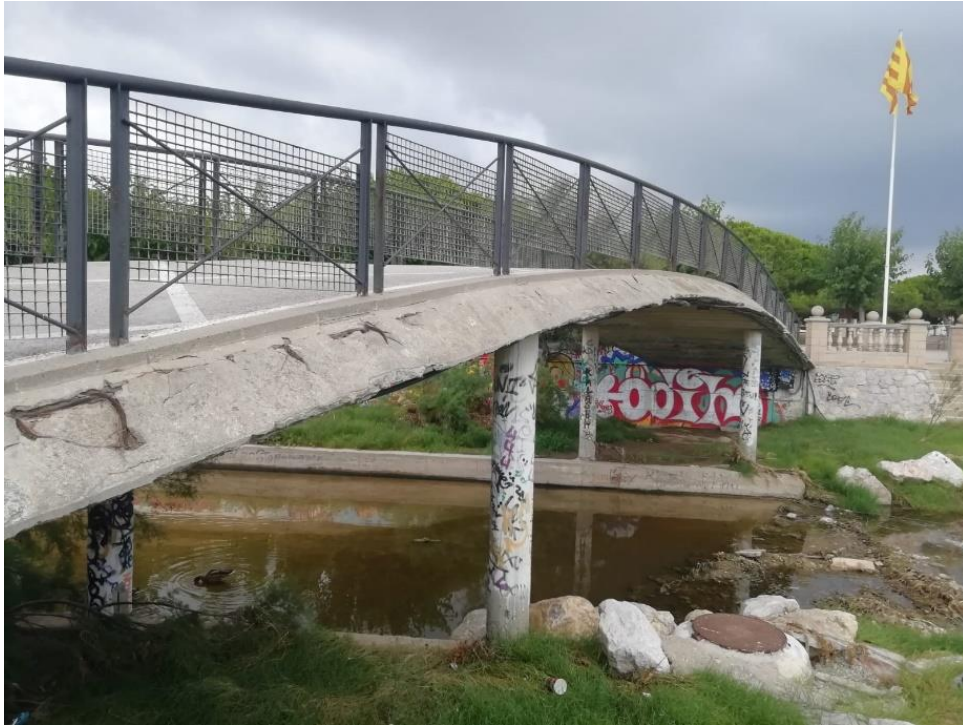
Fotografía 6. Detalle de cubierta existente. Fuente: Propia.
