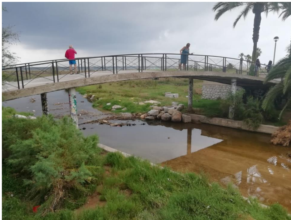
Fotografía 5. Vista de la pasarela a remodelar (hacia la desembocadura). Fuente: Propia.
