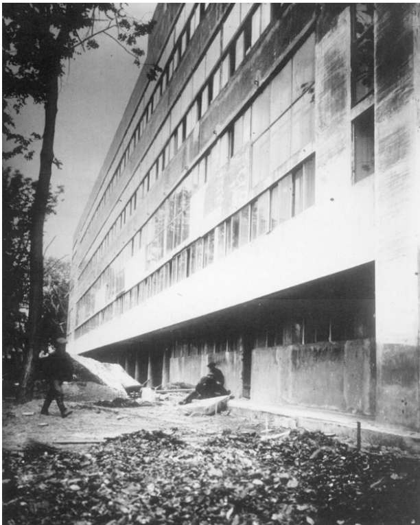
Il. 09. Widok zachodniej elewacji bloku mieszkalnego Domu Narkomfinu. 1929-1930. Źródło: Archiwum Państwowego Muzeum Architektury (Moskwa)
