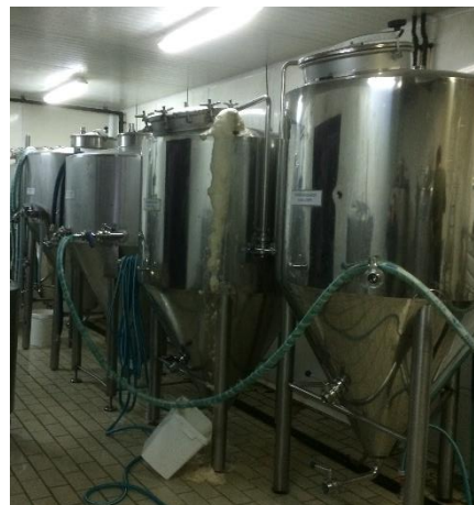
Figura 11. Fermentadors i tancs de maduració amb la opció de purgar el llevat sedimentat a dos nivells diferents. Font pròpia.
