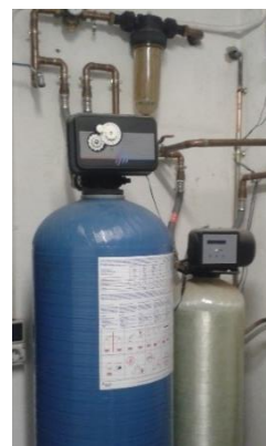
Figura 5. Filtre de carbó actiu per la decloració i descalcificador de l'aigua per l'elaboració de cervesa. Font pròpia.
