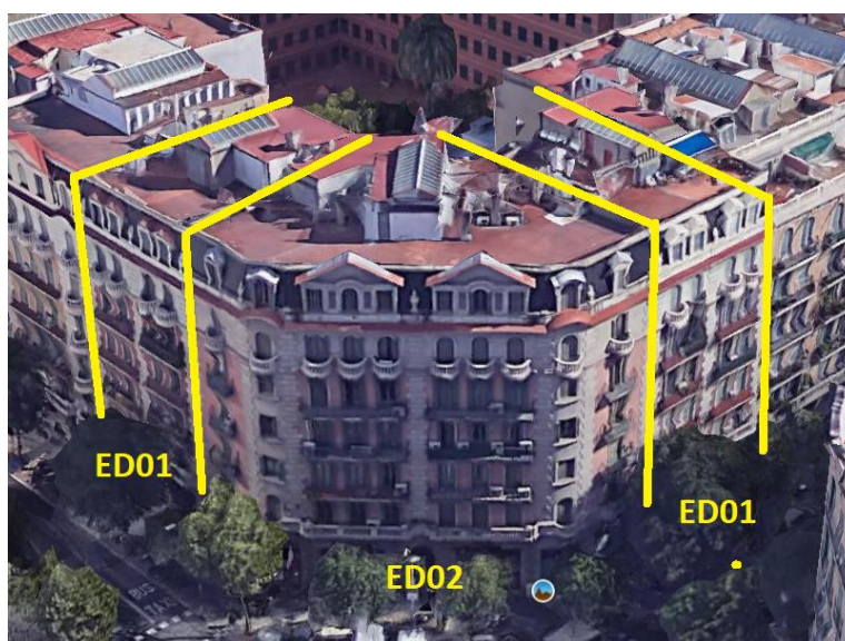
Figura 15: Vista frontal dels edificis d'estudi per aquest treball ubicats a l'eixample esquerre de Barcelona 1
